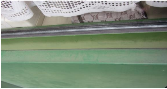
Fassadenelement mit Doppelverglasung U-Wert ca. 3 W/m 2 K
