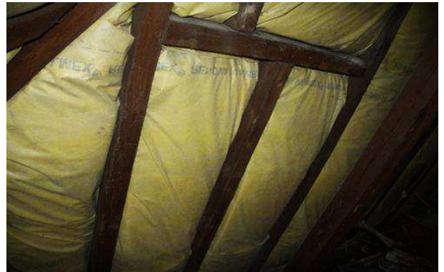
Zwischensparrendämmung im Spitzbodenbereich des alten Rathauses.
