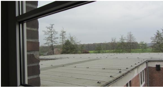
Sanierte Flachdachfläche auf Anbau und Turnhalle
