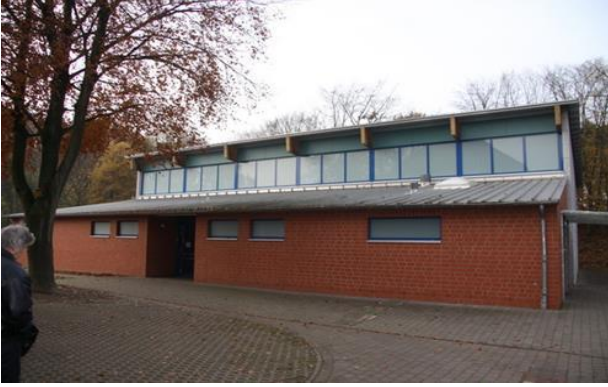
Süd-Ost Seite mit Zugang zur Sporthalle, Fassade verblendet und Fensterband im Hallenbereich.
