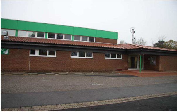
Süd-Ost Wand mit Haupteingang
