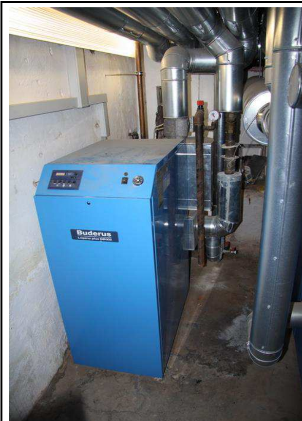
Gas-Brennwertkessel für die Spitzenlast zur Wärmeversorgung des alten und neuen Verwaltungsbaus.
