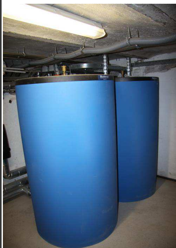
Gas-Brennwertkessel für die Spitzenlast zur Wärmeversorgung des alten und neuen Verwaltungsbaus.
