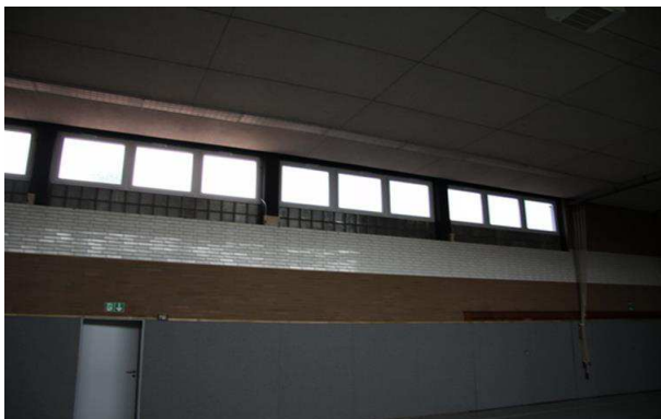
Neue Fensterreihe auf der Süd-Ost Wand oberhalb der gedämmten Glasbausteinwand.
