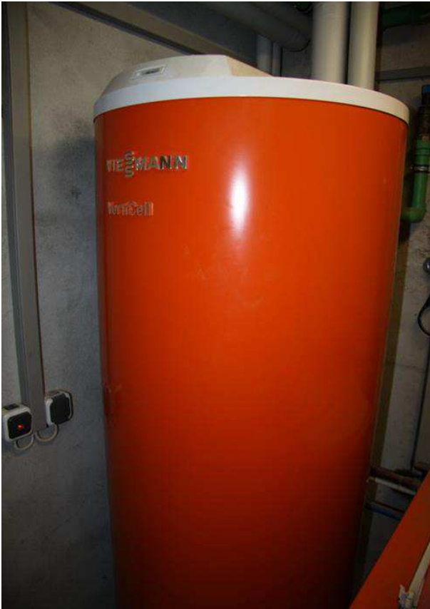
Warmwasserspeicher
