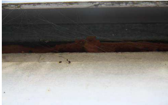
Fehlerhafter Fenstereinbau unterhalb der Alu-Fensterbankabdeckung. Der verwendete Abdichtungsschaum zersetzt sich. Der Zwischenraum zwischen Fensterrahmen und Auflager ist mangelhaft ausgeschäumt. Zusätzlich fehlt eine äußere Abdichtung.
