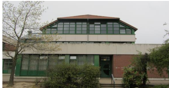
Süd-Ansicht: Beton-Vorhang-Fassade und nachträglich aufgesetztes Dachgeschoss
