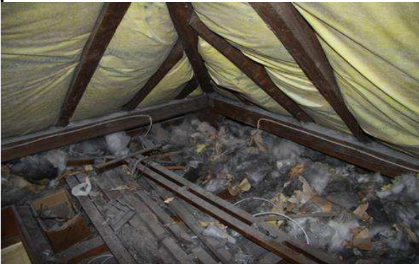
Mangelhafte Dämmung der obersten Geschossdecke
