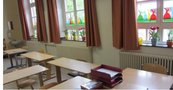
Beheizung der Klassenräume über Radiatoren
