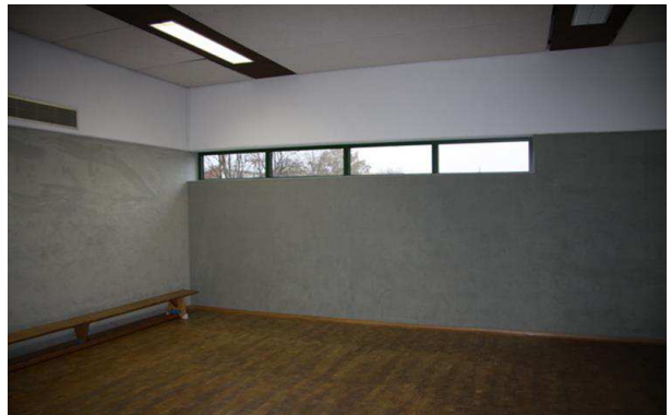
Austausch der Industrieverglasung durch eine aufgemauerte Brüstung mit neuen Oberlichtern
