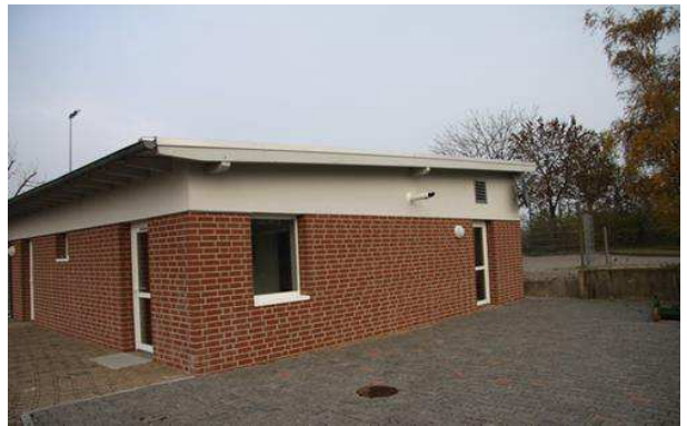
Süd-Seite mit Zugang zum Technikraum.
