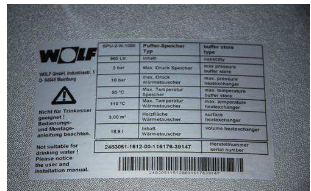
Typenschild des Warmwasser-Pufferspeichers
