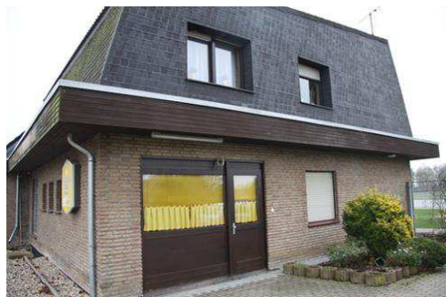
West-Giebel des Vereinsheim mit Platzwartwohnung im Obergeschoss
