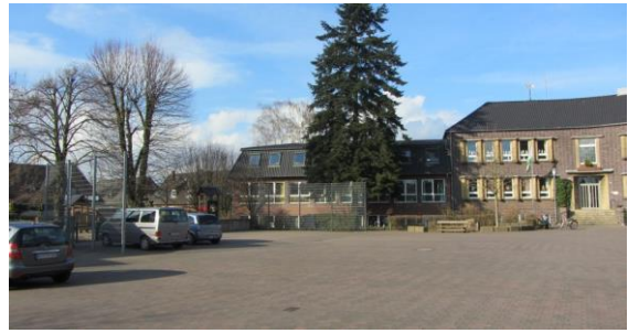
westlicher Anbau der Grundschule mit ausgebautem Dachgeschoss
