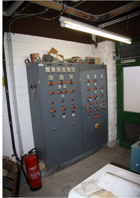
Alte Heizungssteuerung
