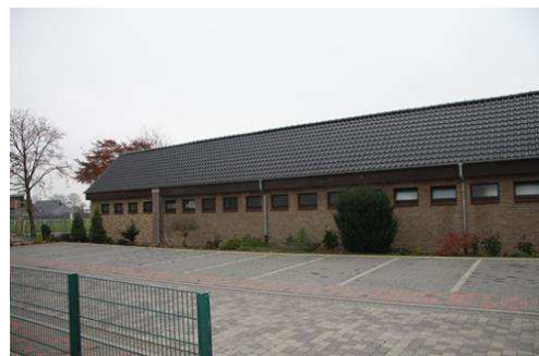
Nord-Seite der Umkleieräume sowie neue Anbau im letzten Viertel des Sportheims.
