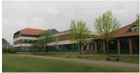
Nord-West-Ansicht, Altbau mit Flachdach in der Mitte
