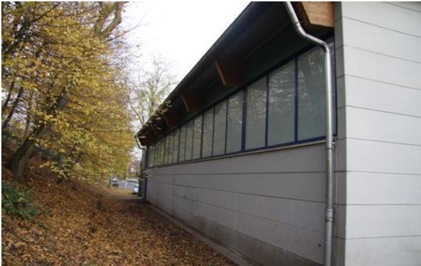
Nord-West Seite der Sporthalle mit Gasbeton-Fassadenplatten und Fensterband.
