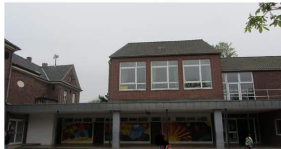
Nord-Ansicht des Anbaus (Baujahr 1960er Jahre)
