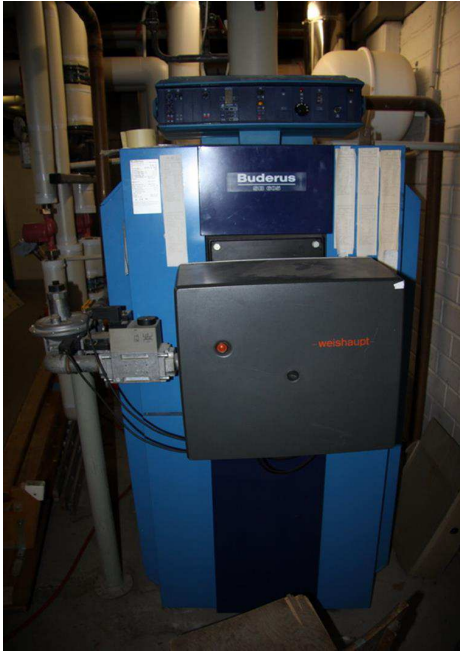
Brennwertkessel von 1996
