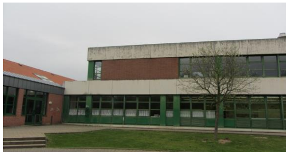
Großflächige Fassadenelemente in Pfosten-Riegel-Konstruktion
