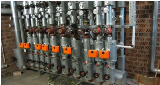
Heizungsverteilung vollständig gedämmt mit geregelten Pumpen
