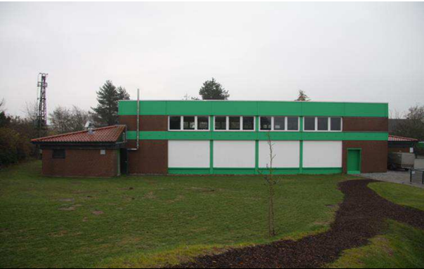
Nord-West Seite mit gedämmten Wandflächen der ehemaligen Glasbausteinfenster.
