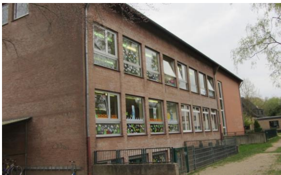
West-Ansicht des Neubaus / teilweise erneuerte Fenster
