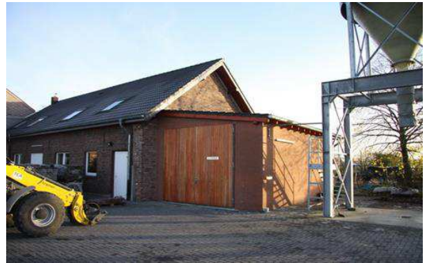
West-Seite und Süd-Giebel des Betriebsgebäude.
