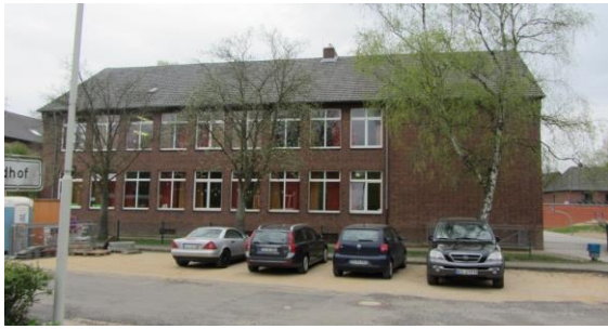
Süd-Seite des Altbaus entlang der Straße Zum Wald
