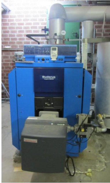
Erdgas-Spitzenkessel mit Brennwertechnik Bj. 1988
