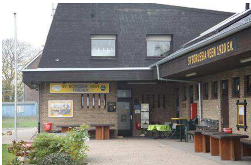
Ost-Seite des Vereinsheim mit Wohnung des Platzwartes im Obergeschoss
