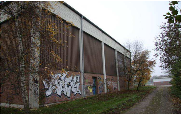
Nordansicht der Sporthalle
