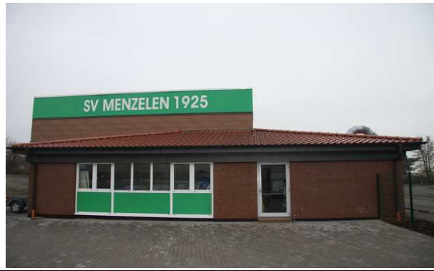
Süd-West Wand der Sporthalle
