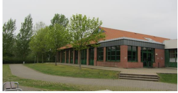
Süd-Ost-Ansicht des Anbaus Baujahr 1999
