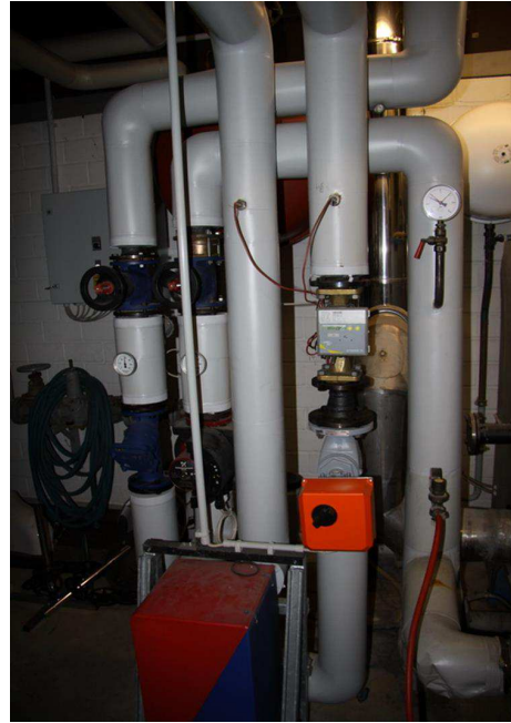
Fernwärmeanschluss
