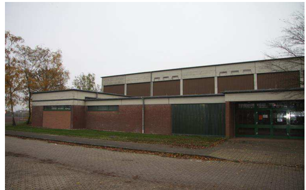
Westansicht der Sporthalle mit Erneuerung der Außenwand im Bereich der Gymnastikhalle
