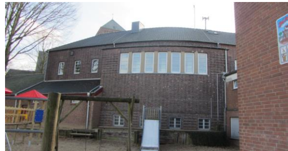
Nord-Ansicht des denkmalgeschützten Altbaus
