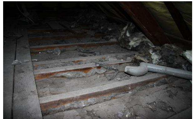
Mangelhafte Dämmung der obersten Geschossdecke
