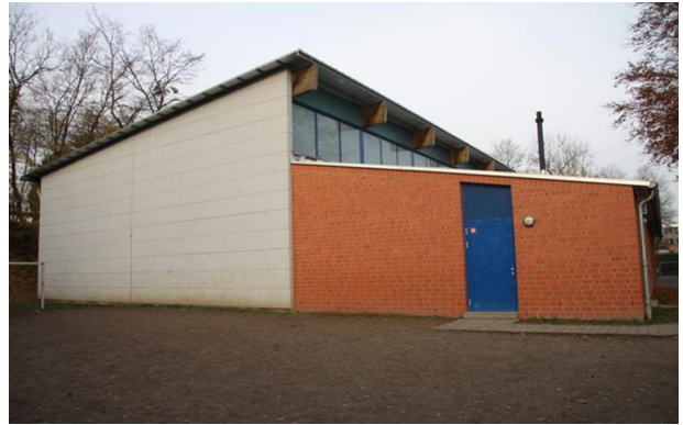
Süd-West Seite mit verblendeter Fassade im Bereich der Umleide und Gasbeton-Fassadenplatten im Bereich der Sporthalle.
