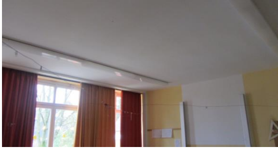
Deckenanbauleuchten mit 2 * 58 W Leuchtstoffröhren und konventionelles Vorschaltgerät (KVG)
