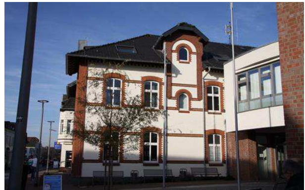
Süd-Ost Seite des "Alten Rathauses" mit Verbindung zum neuen Verwaltungstraktes.
