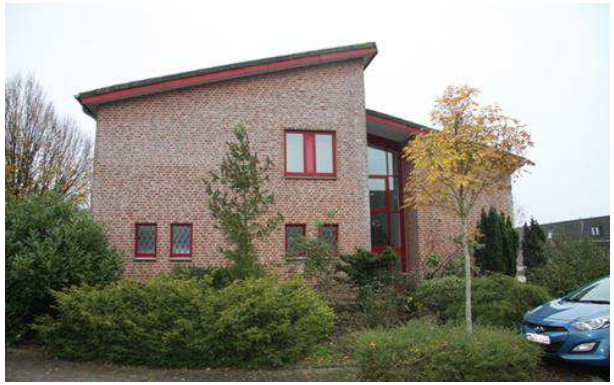
West-Seite mit Fenster des Treppenhauses
