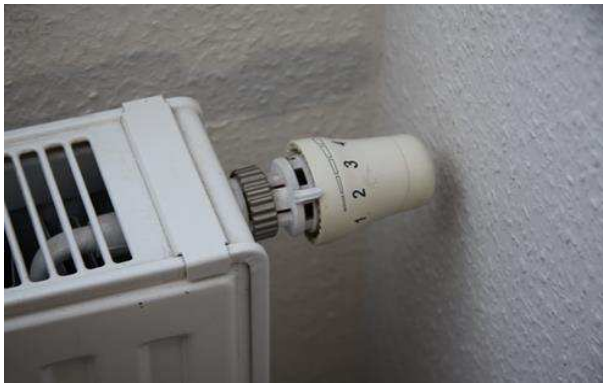
Neuer Heizkörper mit 1K-Ventil und Thermostat im Aufenthaltsraum des ausgebauten Dachgeschosses
