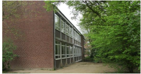
Süd-Ansicht des Anbaus mit großen Böschungsfenster zum Kellergeschoss
