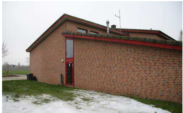
Ost-Seitengiebel der Fahrzeughalle
