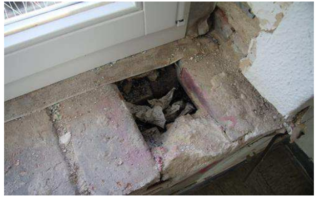
Hohlraumverfüllung mit graphitummantelten Styrophorkugeln.
