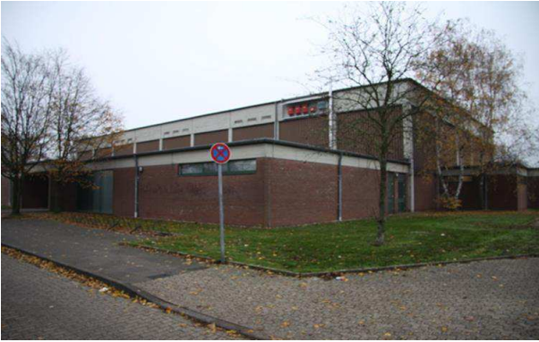
West- und Südansicht der Sporthalle
