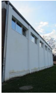
Nord-Fassade der Turnhalle
