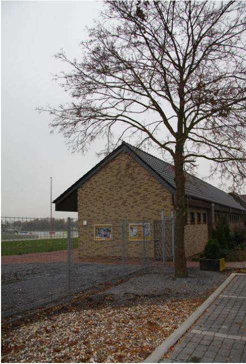
Ost-Giebel des neuen Umkleideanbaus.
