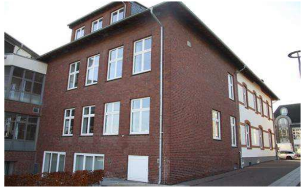
Ansicht auf die Nord-West und Nord-Ost Seiten des "Alten Rathauses"
