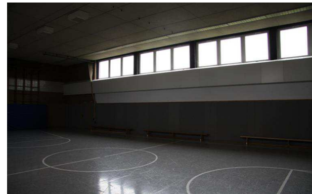
Innenansicht zur Nord-West Wand mit Heizkörper unter den neuen Fenster
