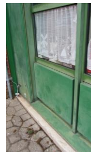
Fassadenelement mit Dämmelement im Sockelbereich
