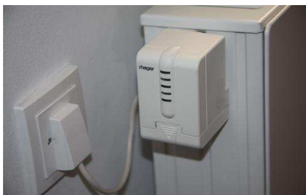
Elektro-Durchlauferhitzer für die Warmwasserversorgung in den Tee-/Kaffeeküchen.
