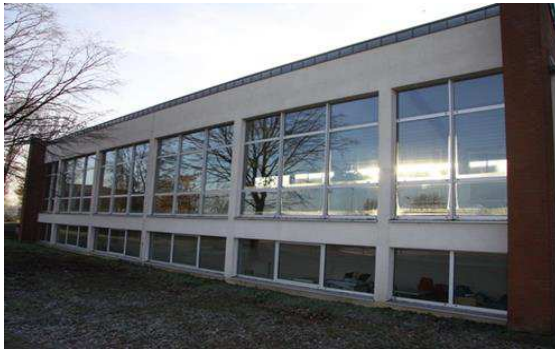
Neu angebauter Bereich mit WDVS auf der Nord-Seite
