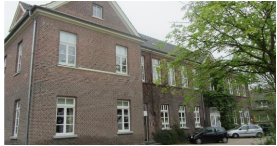
Süd-Ost-Ansicht des Altbaus
