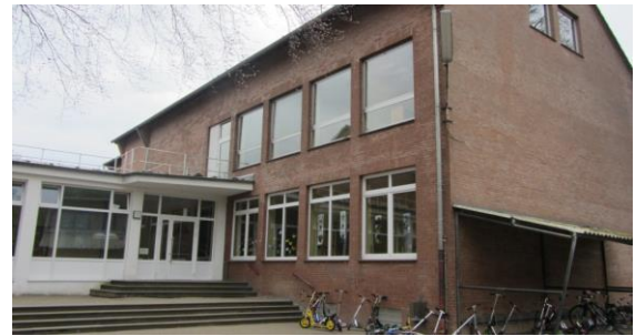
Alu-Rahmenfenster mit Einfachvergasung im 1. OG, Wärmeschutzverglasung im EG
