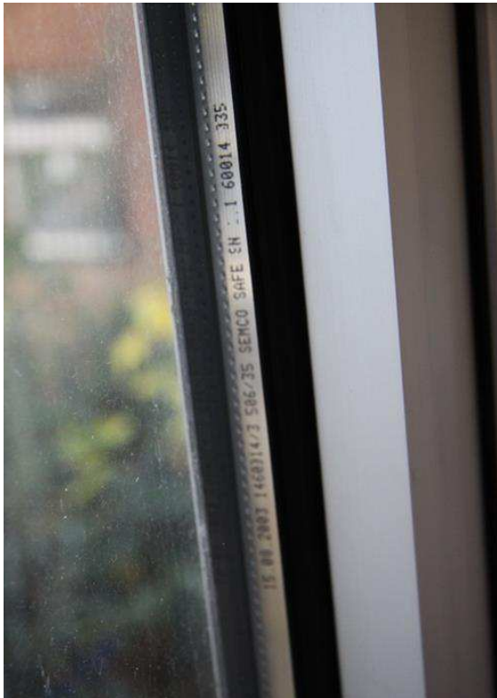
Einprägung im Glasbereich des Alu-Rahmens mit Erstellungsdatum 15.08.2003
