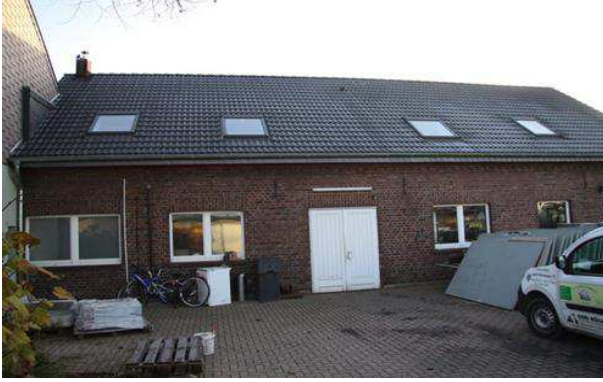
West-Seite des Betriebsgebäudes mit Werkstattzugang
