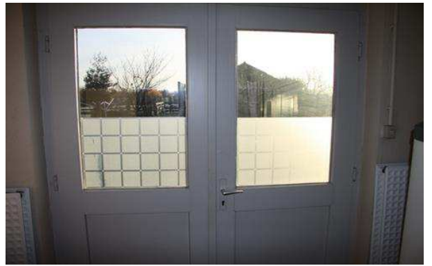
Alte Eingangstür mit Ein-Scheibenverglasung
