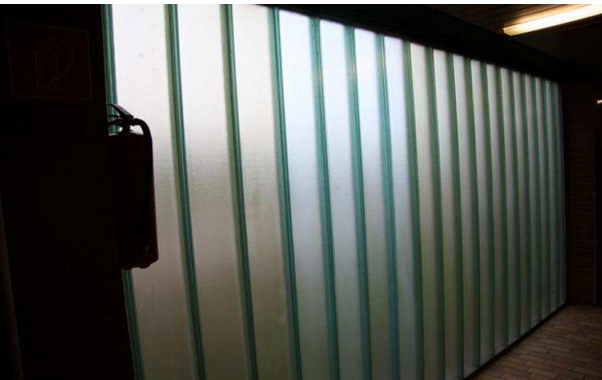
Industrieverglasung durch U-Schalen im Bereich des Foyers
