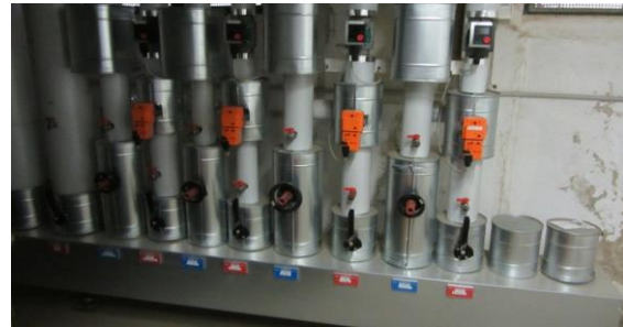
Heizungsverteilung mit vier getrennten Heizkreisen und geregelten Effizienz-Pumpen
