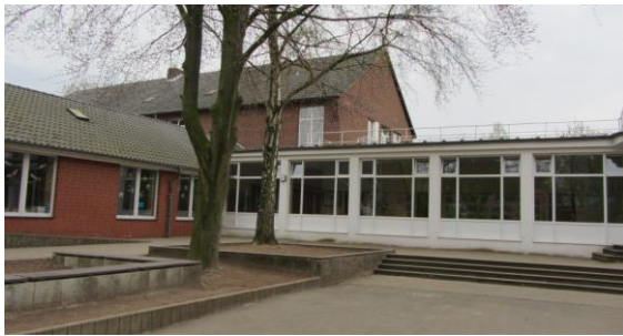
Pausenhalle mit 2005 erneuerter Fensterfront
