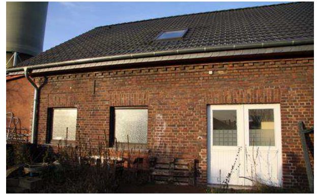
Ost-Seite des Betriebsgebäudes mit alter Eingangstür
