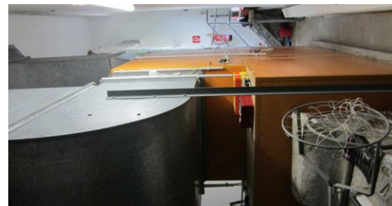
Lüftungsanlage aus 70er Jahren, ohne Wärmerrückgewinnung
