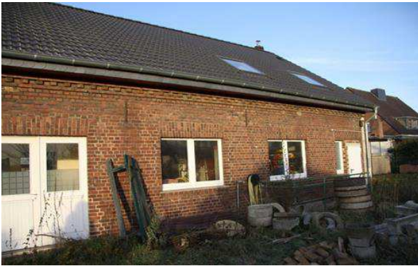
Ost-Seite des Betriebsgebäudes.
