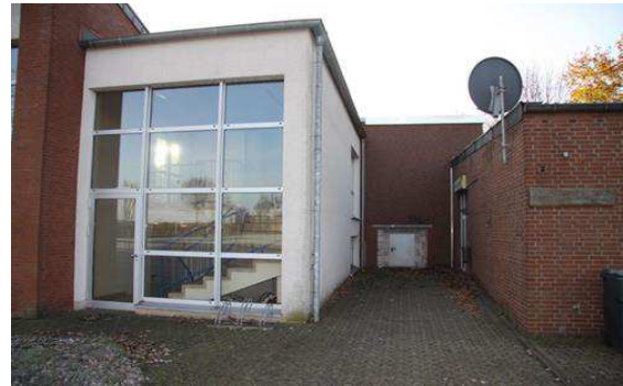
Neues Treppenhaus mit WDVS auf der Nord-Seite des Hallenbades
