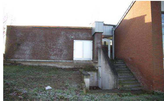
Nord-Seite des Technikraumes mit Ost-Giebel des Schwimmhallenbereichs.
