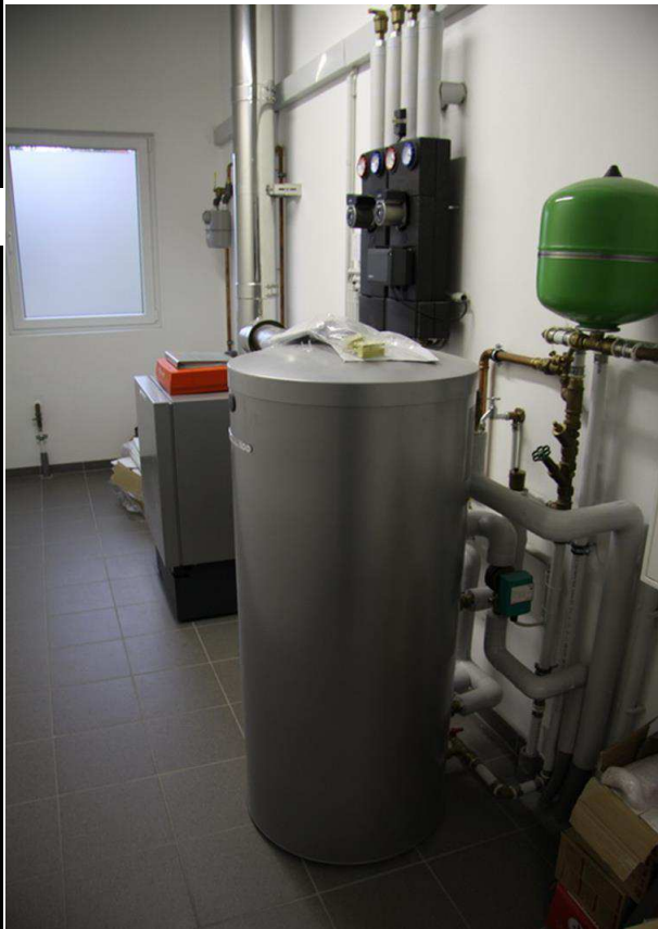
Warmwasserspeicher
