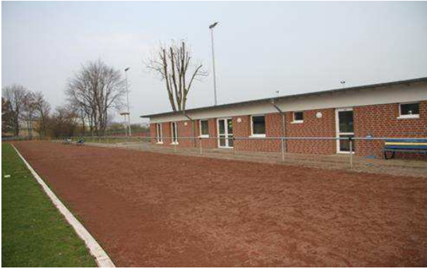
West-Seite des neuen Vereinsheim in Alpen mit Zugang zu den Umkleidekabinen
