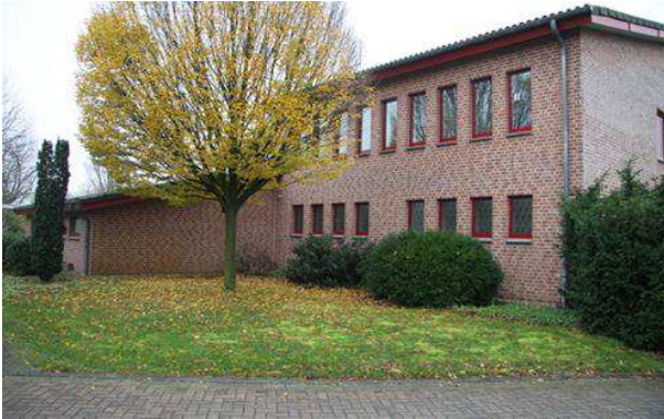
Nordseite des Hauptgebäudes und der Fahrzeughalle.
