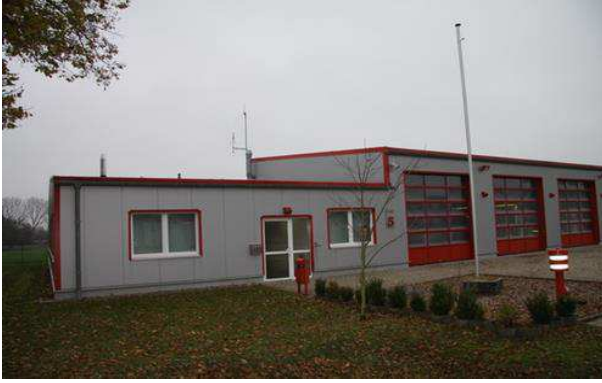
Südwest-Wand mit Büro- und Hallenansicht
