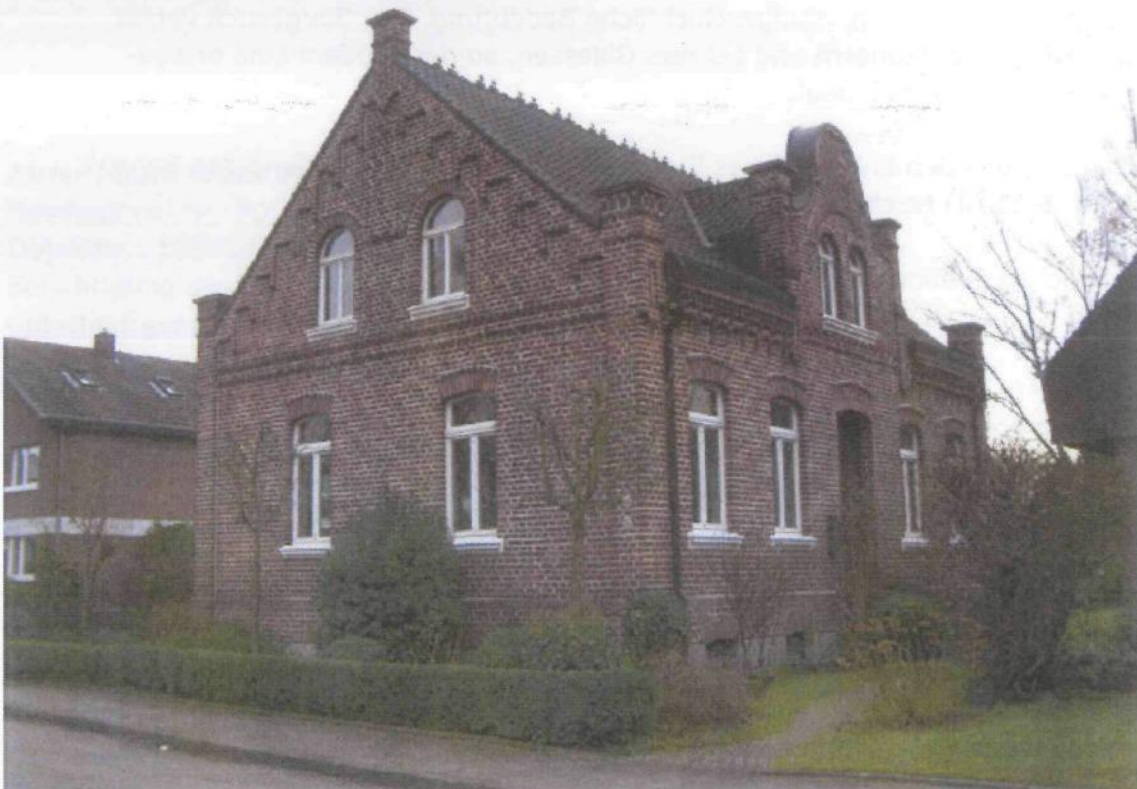
Alpen, Zum Wald 21, Nordwestansicht (Foto UDB Alpen, 2014)
