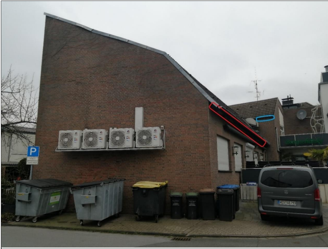
Bild 11: Sicht auf das Gebäude von Südosten. An der rot gekennzeichneten Dachunterkante der Ostseite sind diverse Reste von Mehlschwalbennestern zu sehen. An der blau gekennzeichneten Dachunterkante der Südseite weisen mehrere Schmelzspuren auf Nistplätze hin, die von Mauerseglern oder Haussperlingen genutzt wurden (vgl. Bild 12). (eigene Aufnahme, 04.03.2024)
