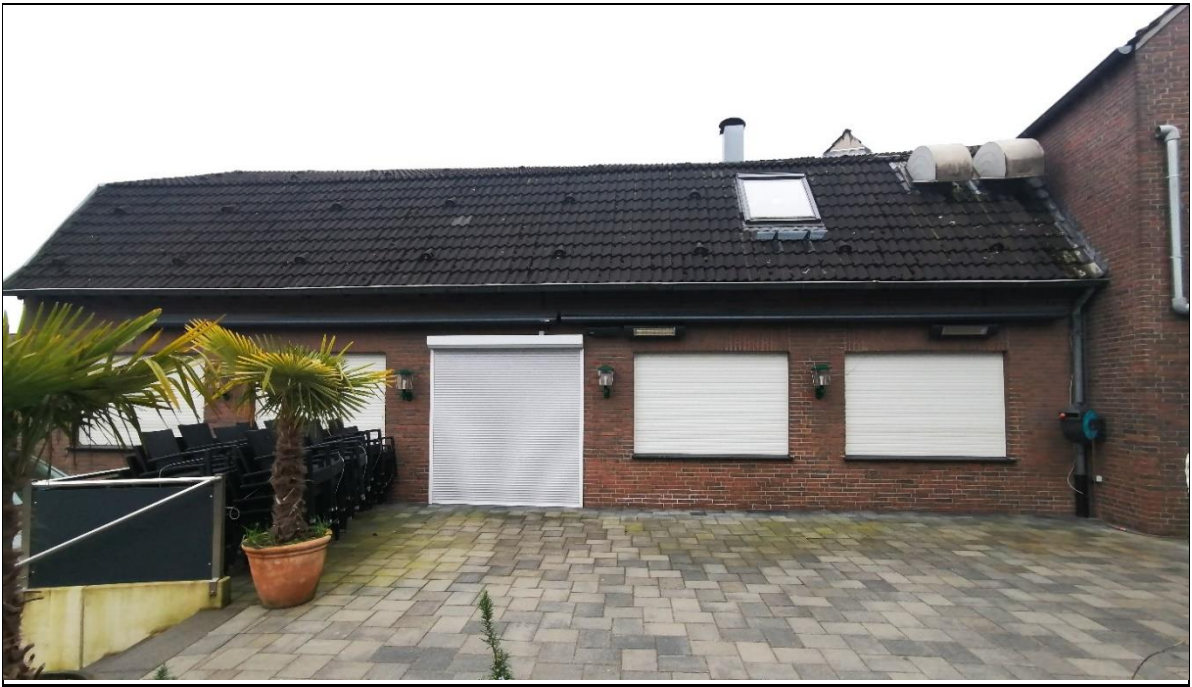
Bild 2: Ansicht östliche Seite des rückwärtigen Vorhabengebäudes von der Haagstraße (eigene Aufnahme, 04.03.2024)
