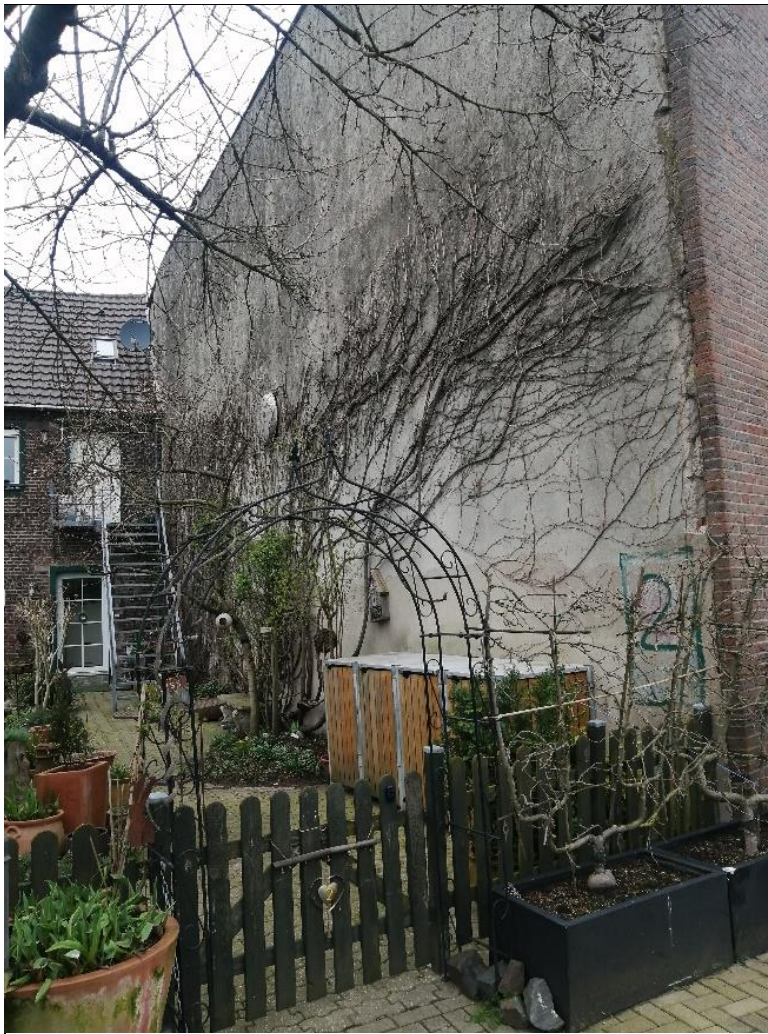
Bild 9: Bewachsene Außenwand an der westlichen Seite des südlichen Anbaus. (eigene Aufnahme, 04.03.2024)
