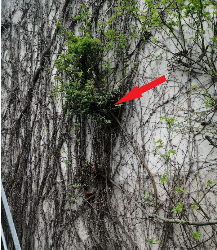
Bild 19: Altes Vogelnest an der westlichen Seite des rückwärtigen Gebäudeteils (eigene Aufnahmen, 04.03.2024)
