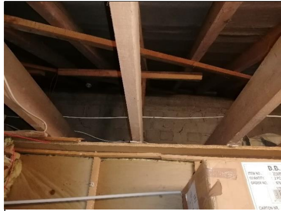
Bild 8: Das Pultdach ist auch an der westlichen Seite gut abgedichtet. Hier die Sicht vom Abstellraum über den Verbau der Kegelbahn. (eigene Aufnahme, 04.03.2024)
