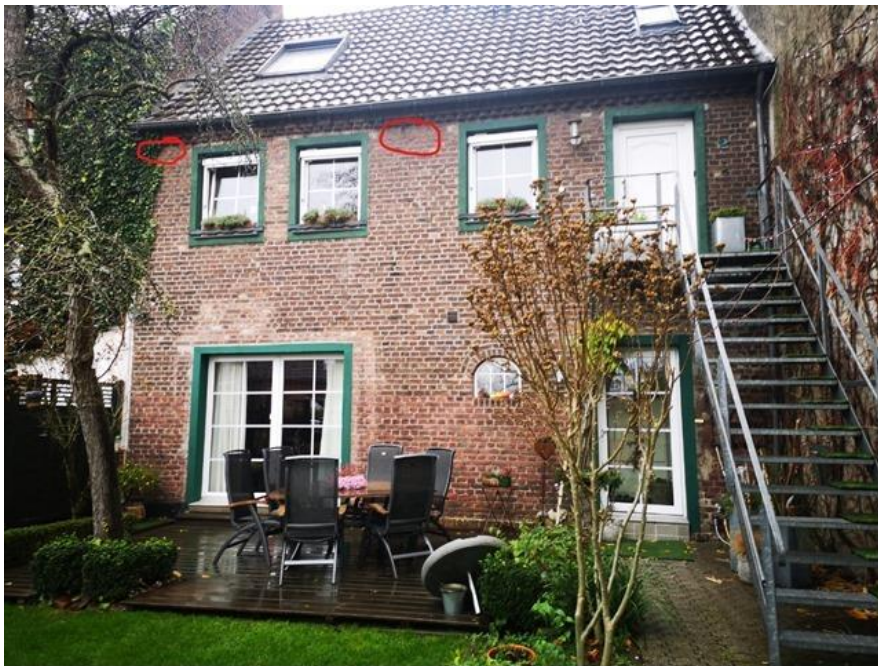
Bild 20: Die roten Markierungen zeigen die Möglichkeiten für die Anbringung der Nisthilfen für Mehlschwalben und Haussperlinge an der Südseite von Gebäude Wallstraße 2. (Aufnahme Architekturbüro Pierre Wetels)
