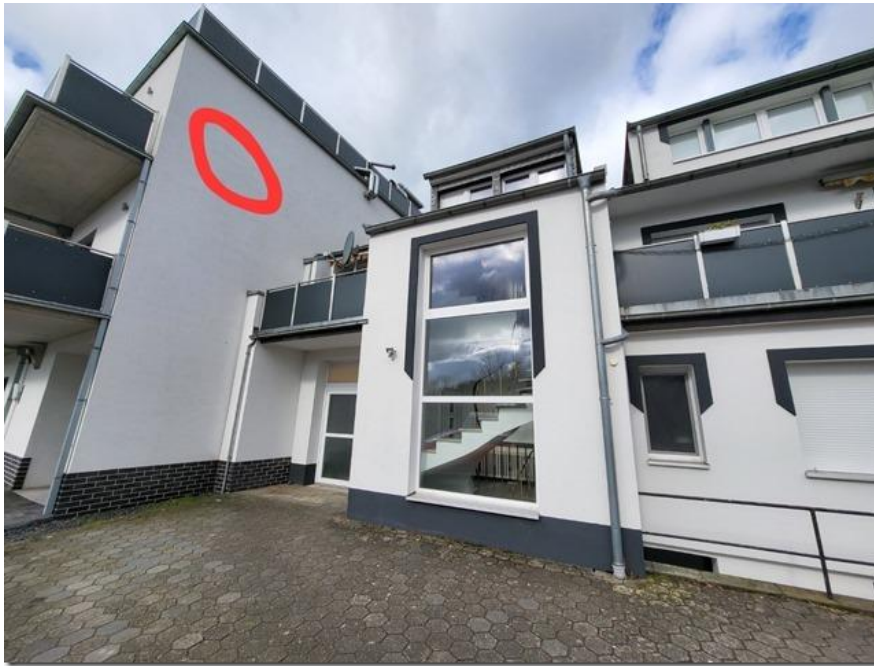
Bild 21: Möglichkeiten für die Anbringung der Nisthilfen für Mauersegler an der östlichen Seite von Gebäude Burgstraße 36/38. (Aufnahme Architekturbüro Pierre Wetzels)
