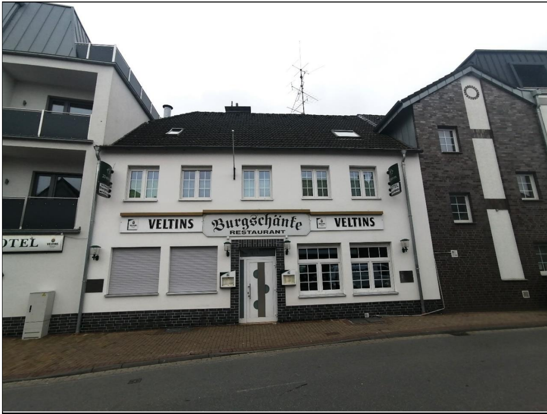
Bild 1: Ansicht des Vorhabengebäudes von der Burgstraße (eigene Aufnahme, 04.03.2024)
