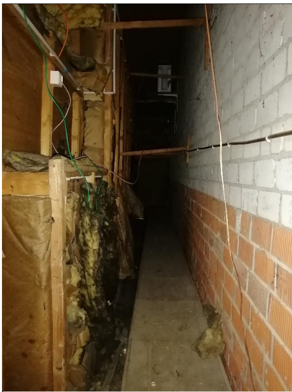
Bild 5: Schmalen Gang auf der westlichen Seite neben der Kegelbahn (eigene Aufnahme, 04.03.2024)
