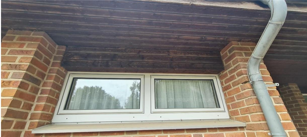
Abb. 9: geschlossene Fenster von außen ohne Rollladenkasten
