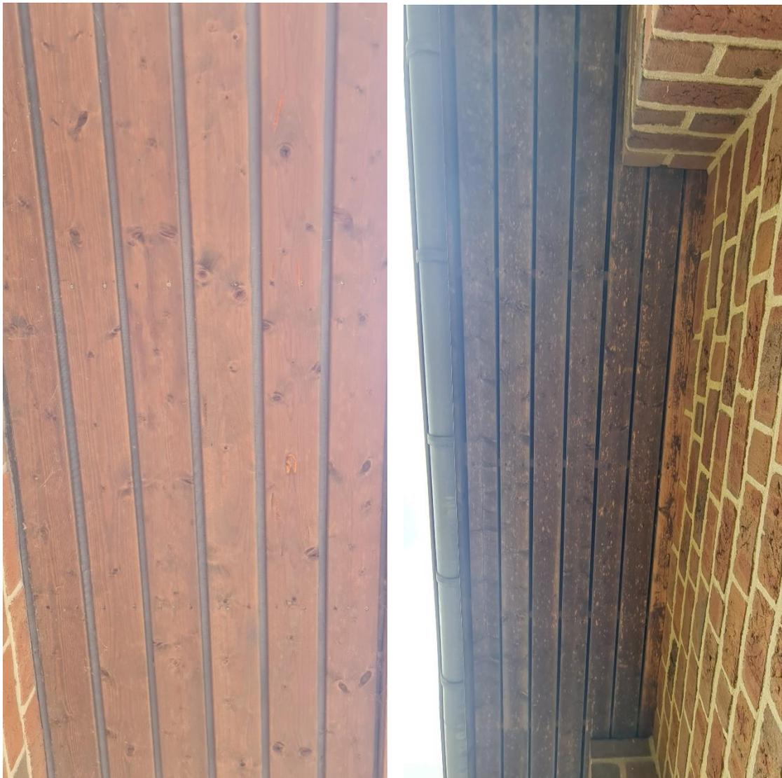
Abb. 20: Dachüberstand mit Holzverkleidung
