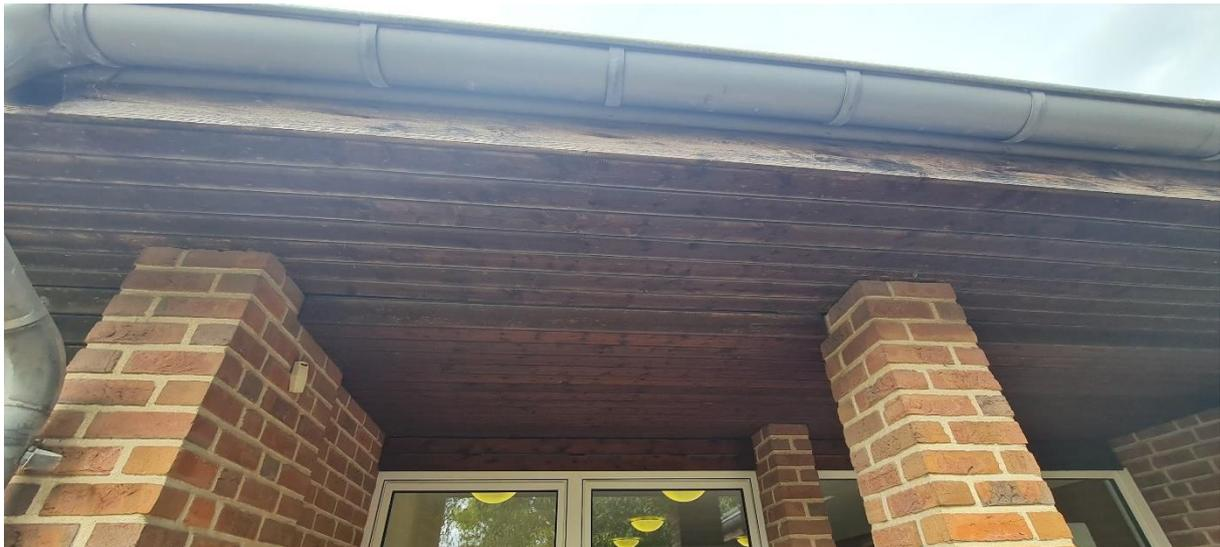
Abb. 19: Dachüberstand mit Holzverkleidung
